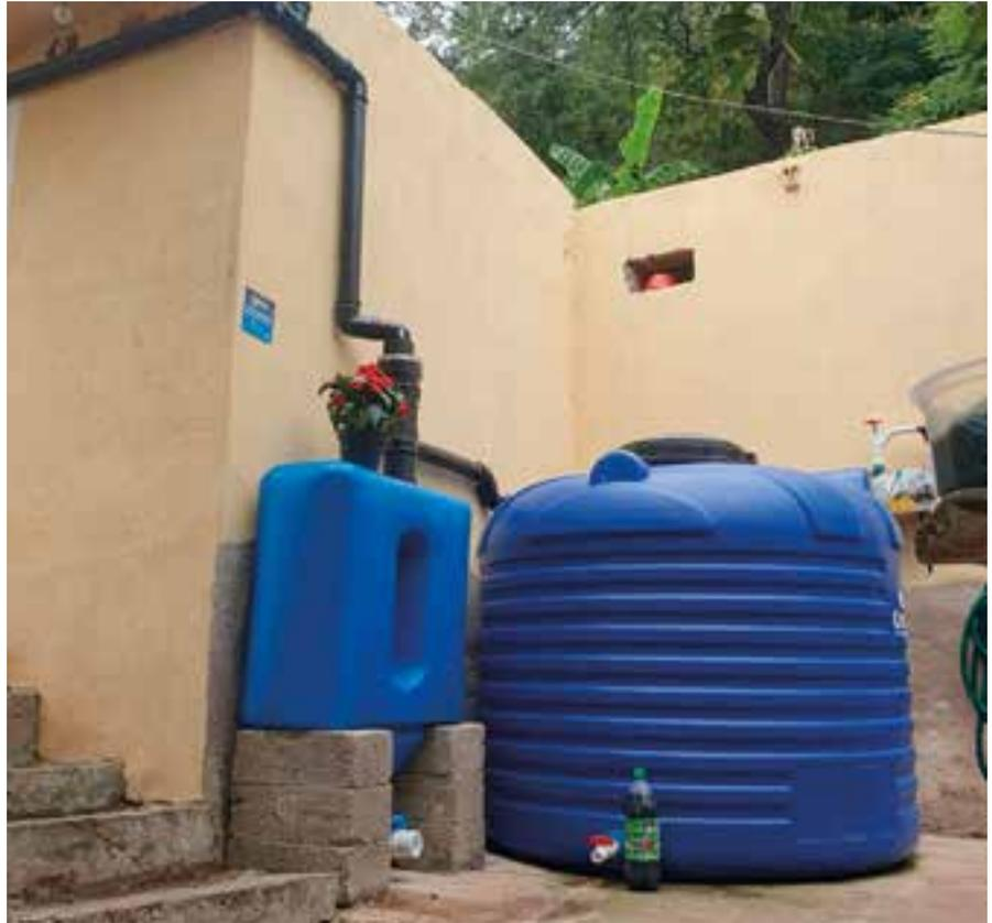
Modelo de sistema de captación de agua pluvial.
